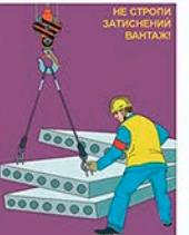
Забороняється піднімати, переміщувати та кантувати залізничний і з невідомою масою вантажі. При роботі необхідно використовувати вантажо-занурювальні стропи із застосуванням відстиков.
